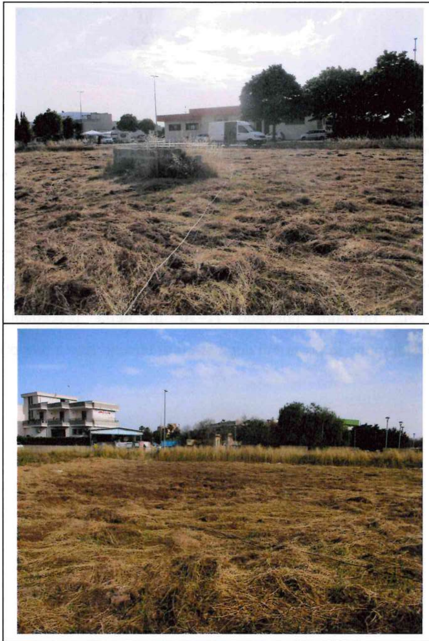
Esecuzione indagine sismica
